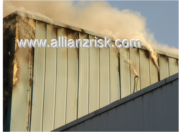
Resim 3: PU izoleli sandviç panellerin içten içe yanış anı
