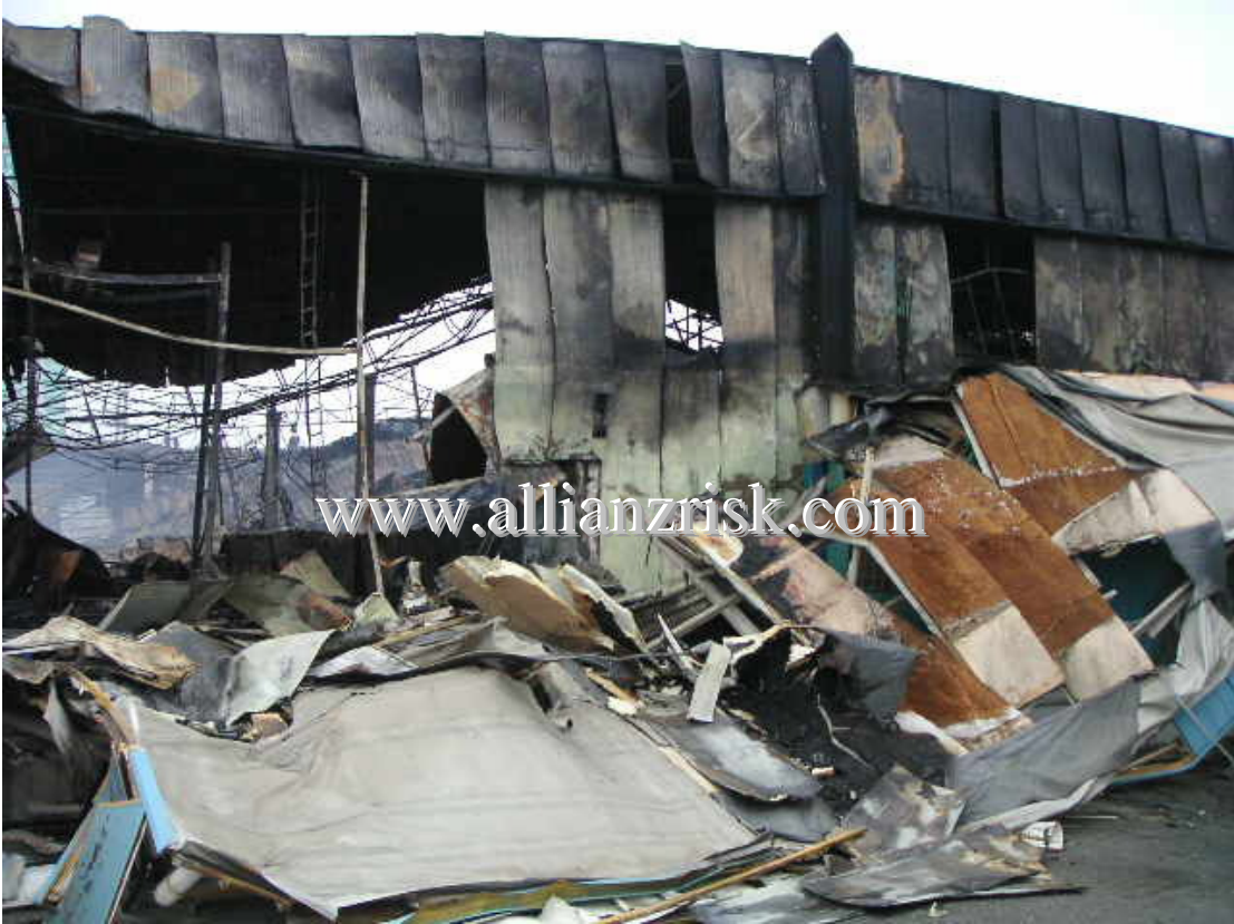
Resim 1: Bir beyazışya deposunda yaşanan büyük bir yangın sonrasında deforme olmuş poliüretan izoleli sandviç paneller
