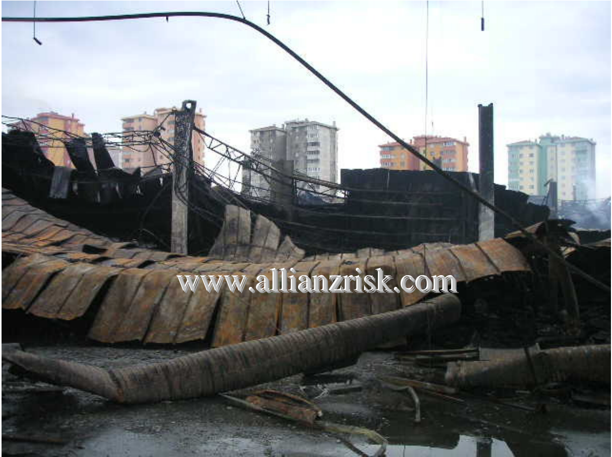
Resim 1: Bir beyaz eşyadeposunda yaşan büyük bir yangın sonrasında deforme olmuş poliüretan izoleli sandviç paneller
