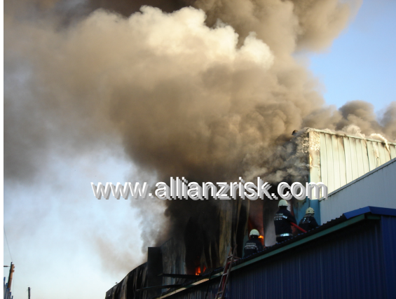
Resim 2: PU izoleli sandviç panellerin yanarken görüntüsü
